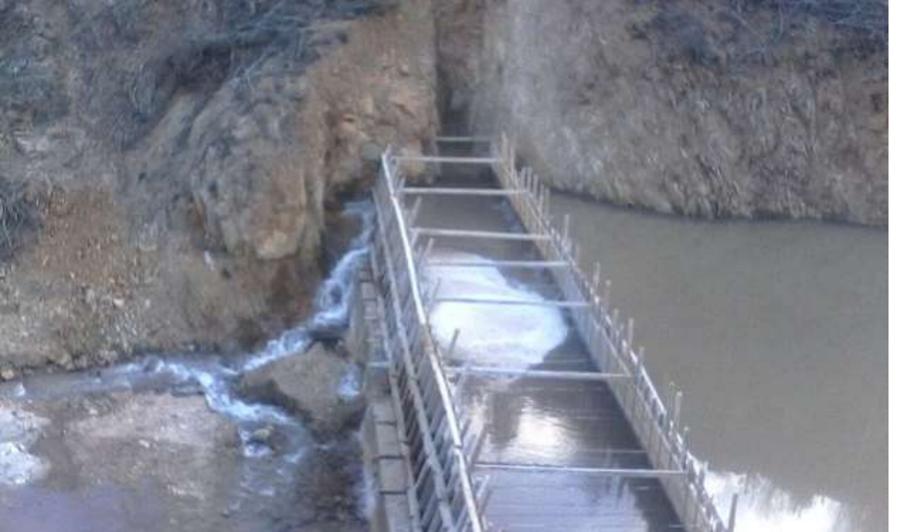
RESİM – 4 ÇAMLIKÖY BETON GÖLETİ
